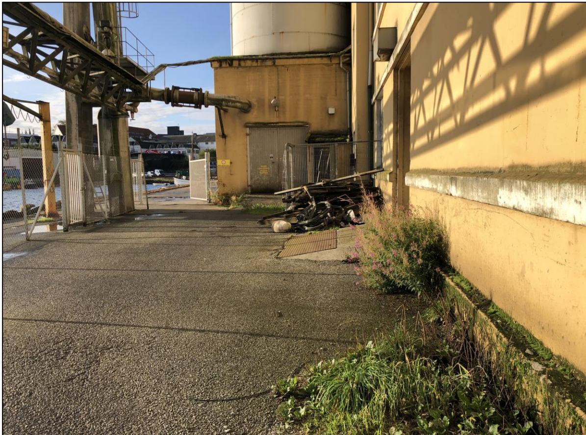
Figur 3. I sprekker mellom bygninger og asfalt og på organisk løsmateriale som har samlet seg i hjørner og langs vegger er det stedvis litt vegetasjon. Foto: Bjarne Homnes Oddane
